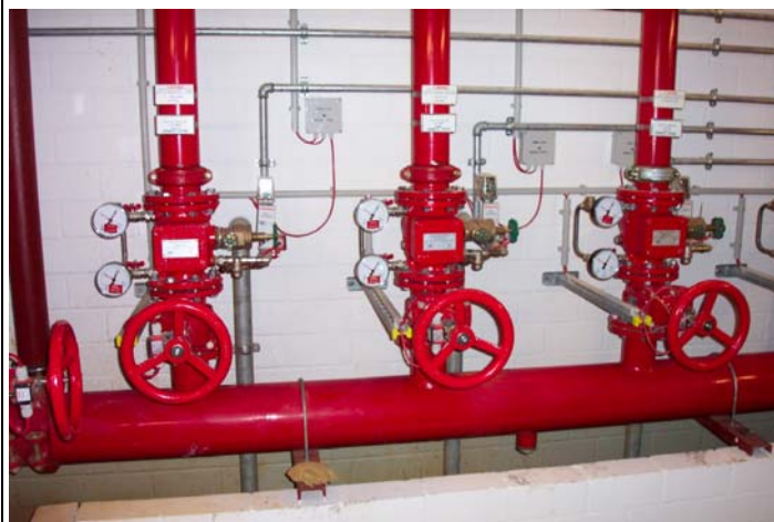
Sprinklerkontrollschieber
